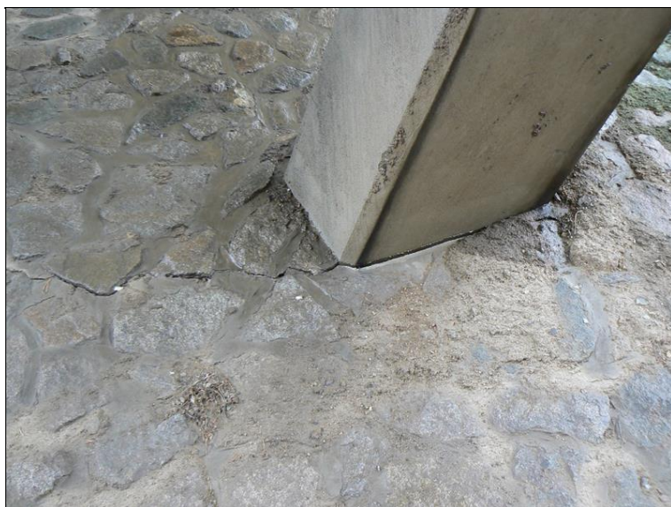
Podélná prasklina odláždění pod patami vzpěr .JPG
