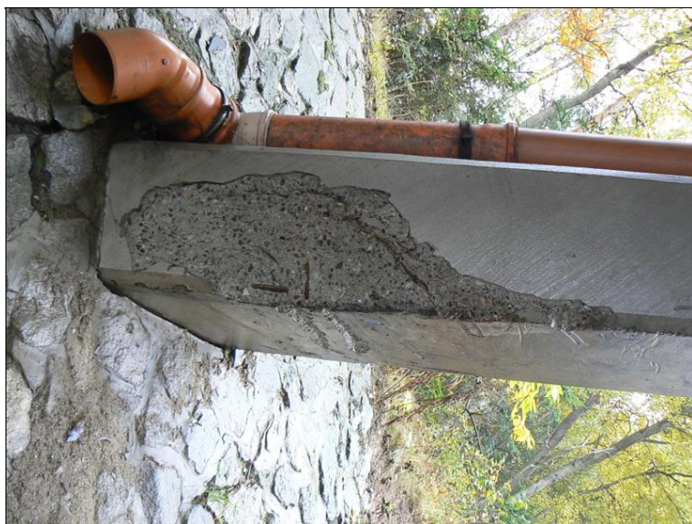
Poškození vzpěry nárazem vozidla.JPG
