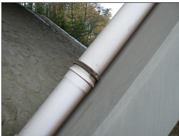
Korodující objímky svodů odvodnění.JPG
