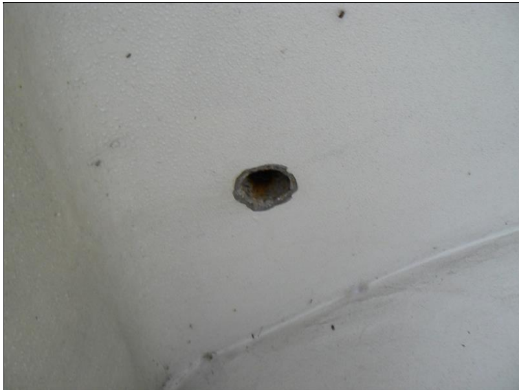
Chybějící trubka odvodnění.JPG
