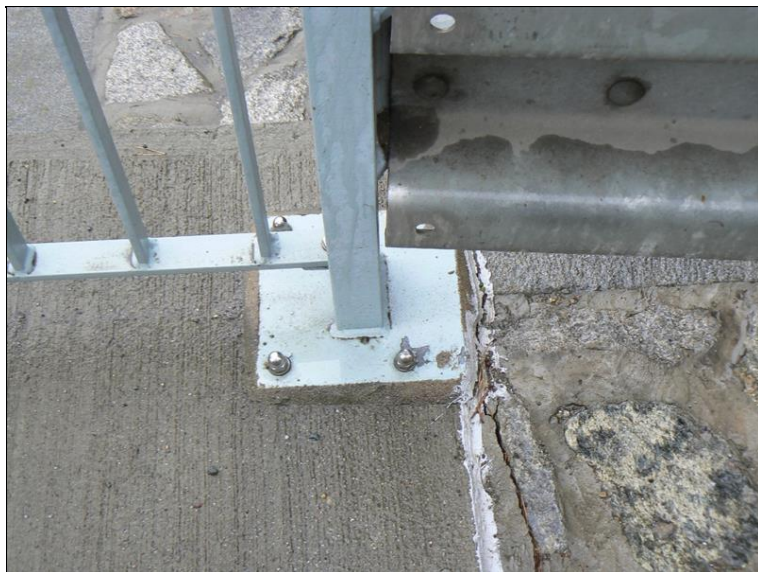
Patní plech sloupku zábradlí na OP4 vlevo zasahuje mimo římsu.JPG
