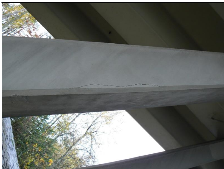
Podélná trhliny na rohu střední vzpěry na PI2.JPG
