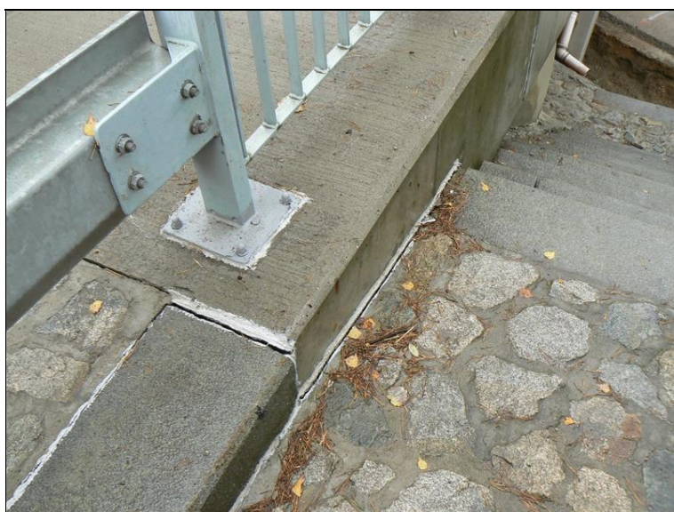
Prasklina na styku schodiště s římsou.JPG
